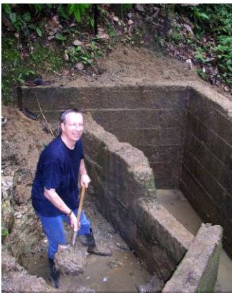
Paul nettoie avec d'autres le point de captage rempli de sable qui alimente Sarayaku.
